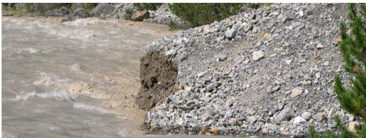
Abb. 3-2: Die regelmässigen künstlichen Hochwasser sorgen unter anderem dafür, dass die in den Spöl ragenden Schuttkegel abgetragen werden und sich so keine Staubereiche bilden können (Foto: Hydra).
